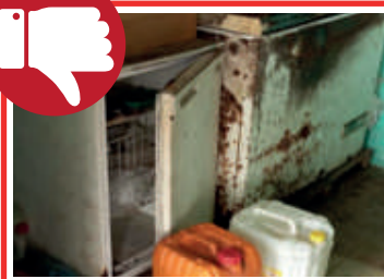
Photo 21 : frigo et congélateur en mauvais état d'entretien
