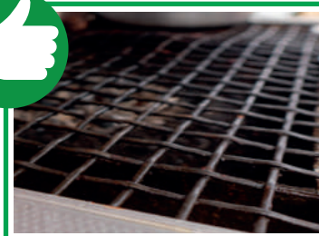
Photo 27 : grillage en bon état d'entretien
