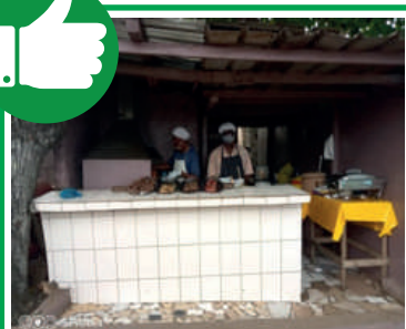
Photo 7 : Sol dallé et carrelé
